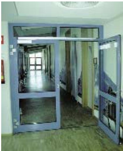
Verglasungen in Rauchschutztüren können aus ESG, VSG und G-Verglasungen mit erhöhter Bruch- und Verkehrssicherheit bestehen
