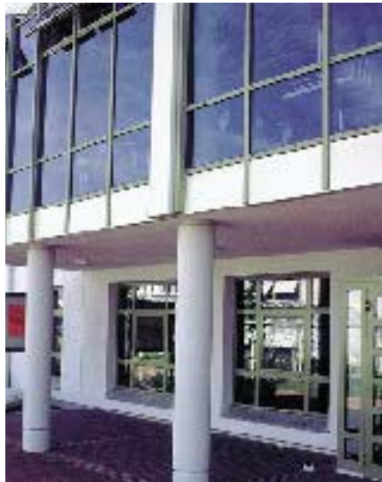
Verglasung der Absturzsicherung aus VSG
