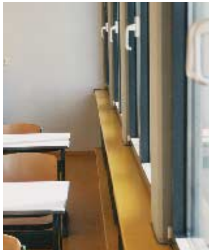
Abschirmung durch eine Fensterbank
