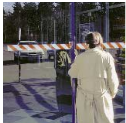
Deutliche Kennzeichnung einer ESG-Verglasung
