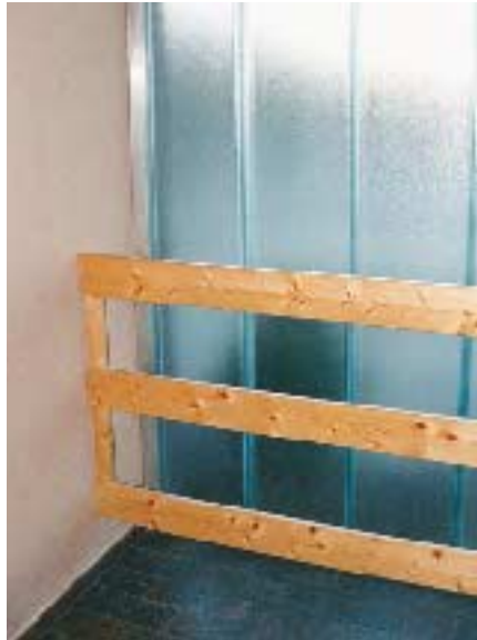
Abschirmung einer Wand aus Profilbauglas
